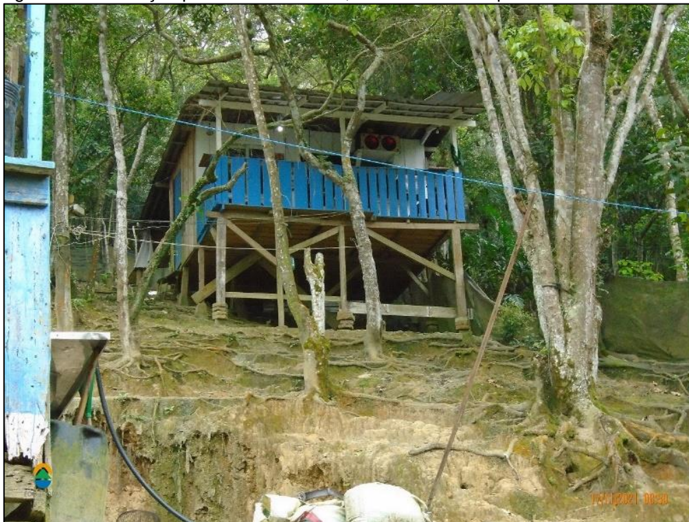
Figura 40 - Edificação presente no Setor E, construída sobre pilotis.
