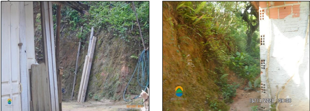
Figura 10 - Afloramento de rocha xistosa em taludes de corte - Vila da Paz.
