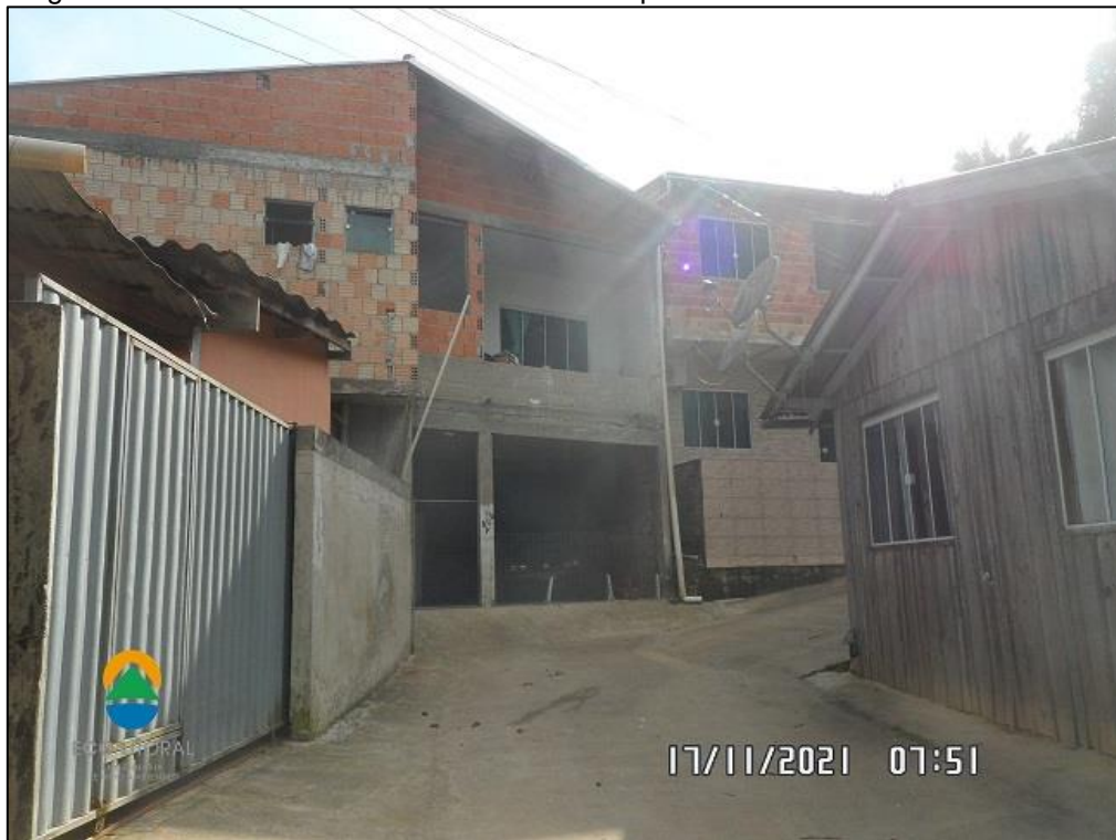
Figura 36 - Padrão construtivo das residências presentes no Setor D.
