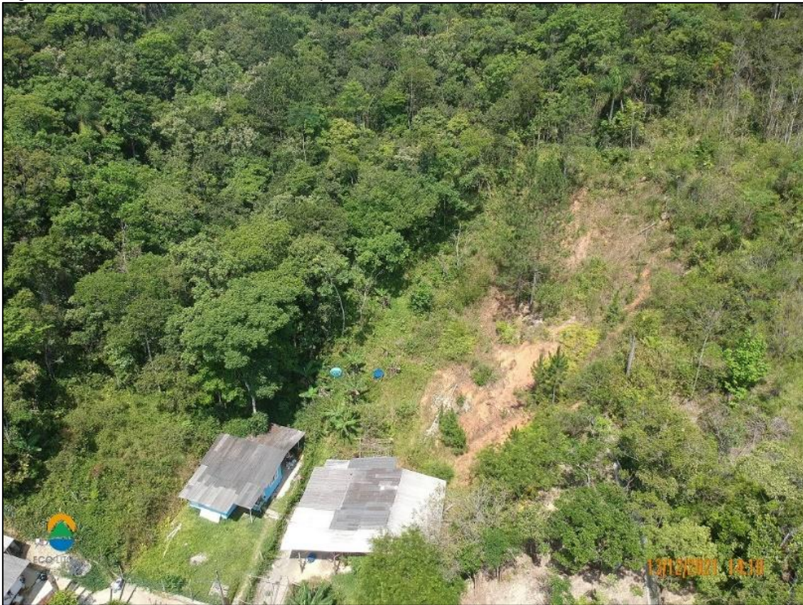
Figura 452 - Cicatriz de deslizamento planar, localizado no Setor E da Vila da Paz.
