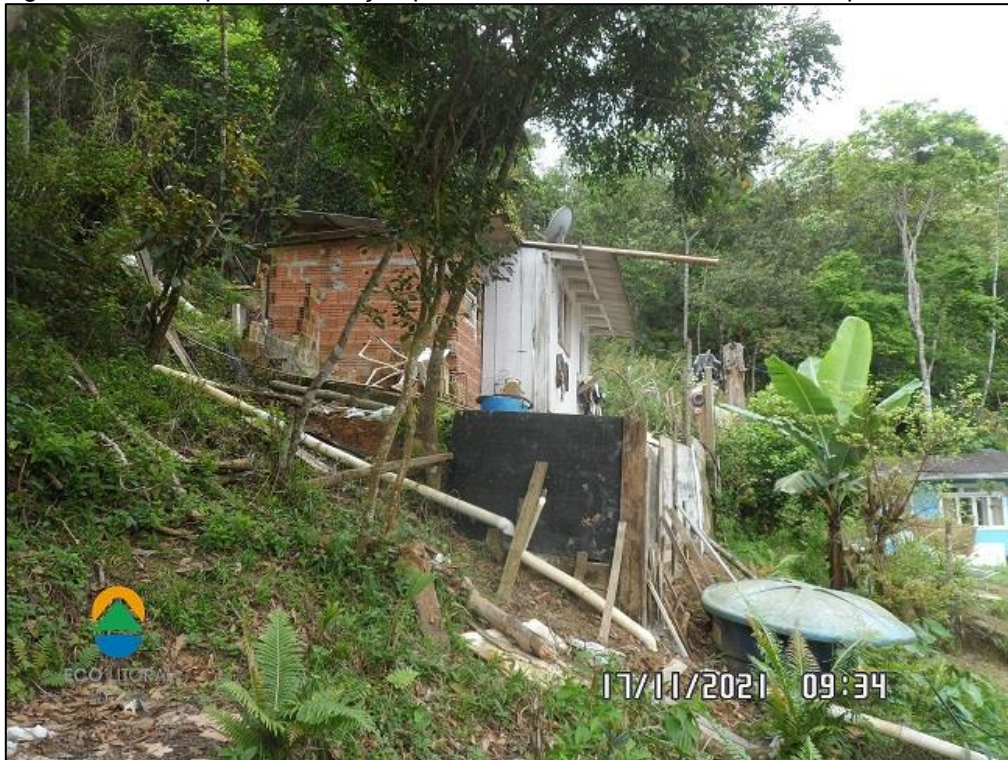
Figura 39 - Exemplo de edificação presente no Setor E, construída no tipo corte/aterro.
