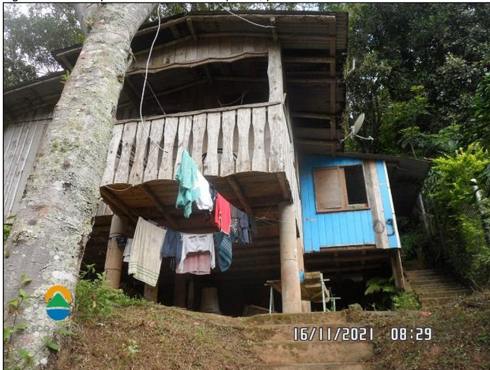
Figura 26 - Exemplo de moradia sobre pilotis, presente no Setor B.
